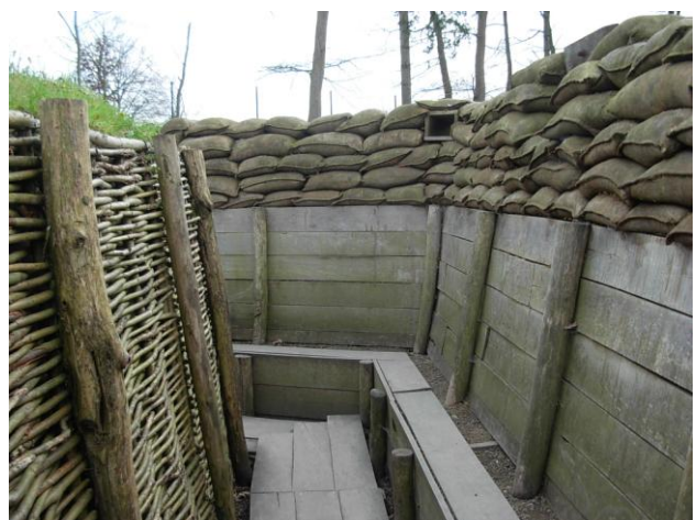
Trench Experience : parcours van gereconstrueerde loopgraven
